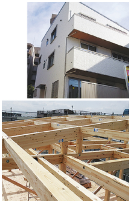
完成した事務所（右）と施工中の様子（下）
